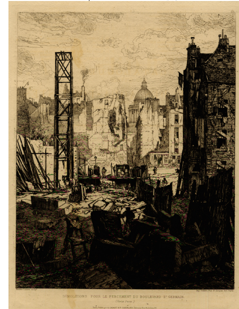
11. Maxime Lalanne (1827-1886) Démolitions pour le Percement du Boulevard St. Germain
